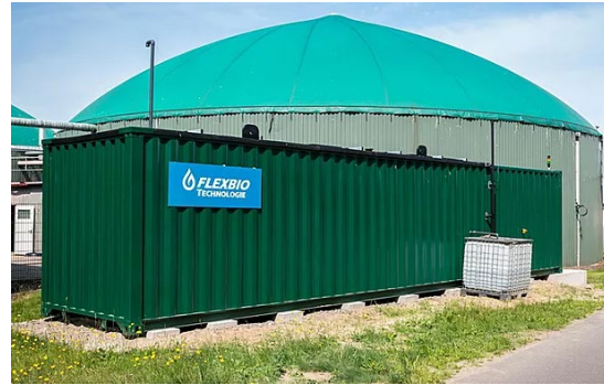
Abwasser aus Landwirtschaft (Rotenburg Wümme) ca. 25 m 3 /d (Direkteinleitung), Anlagentyp AFBB-075
