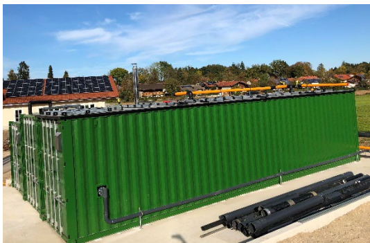
Abwasser aus dem HTC-Prozess (Schweiz Chur) ca. 15 m 3 /d (Indirekteinleitung), Anlagentyp AF-050
